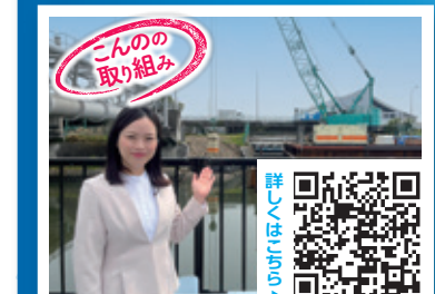
(仮称)戸田公園樋門は着々と工事
