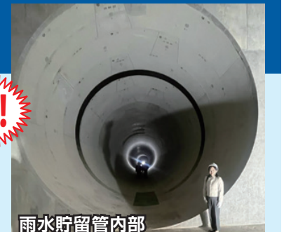
雨水貯留管内部
